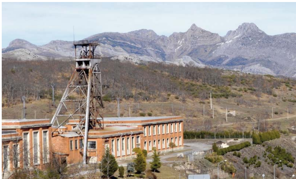
Figura 15. Panorámica de los alrededores de Sahelices de Sabero; puede observarse el alto valor paisajístico de la zona, y la presencia de infraestructura mineras.
